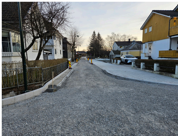
Arbeid i Hannadalsgate, Stavanger kommune Foto: Bymiljøpakken
