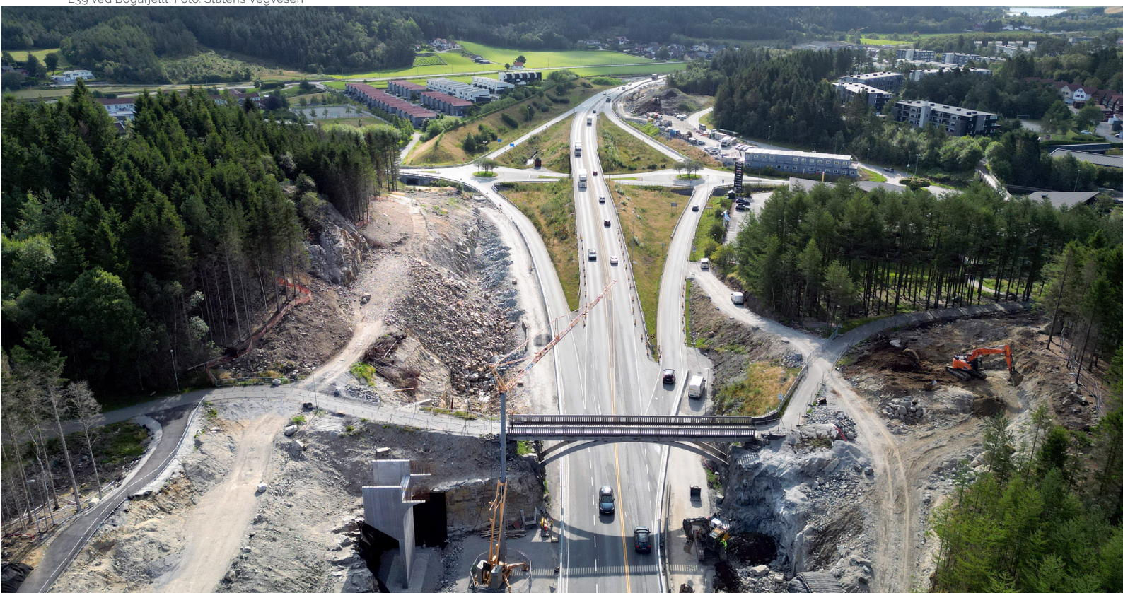
E39 ved Bogafjell. Foto: Statens Vegvesen
