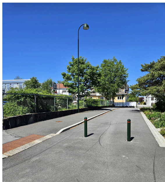
Myrvangveien i Stavanger. Foto: Bymiljøpakken
