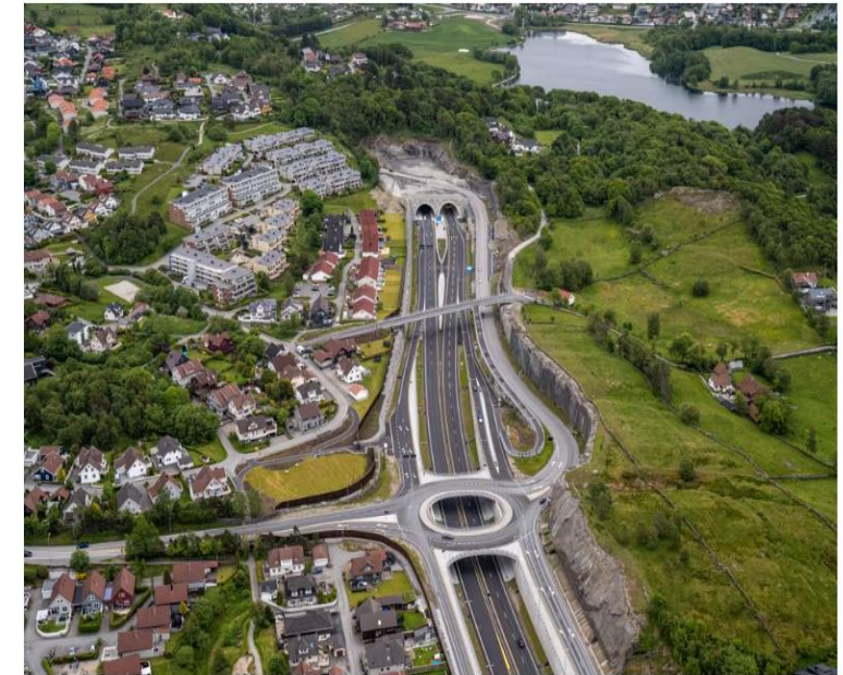
Eiganestunnelen i Stavanger sett fra nord, ved Tasta. Etter åpningen økte biltrafikken på E39 her med 16 prosent – mens byvekstavtalen med fylkeskommunen og staten forutsetter nedgang i biltrafikken. Foto: Jarle Aasland, Stavanger Aftenblad
