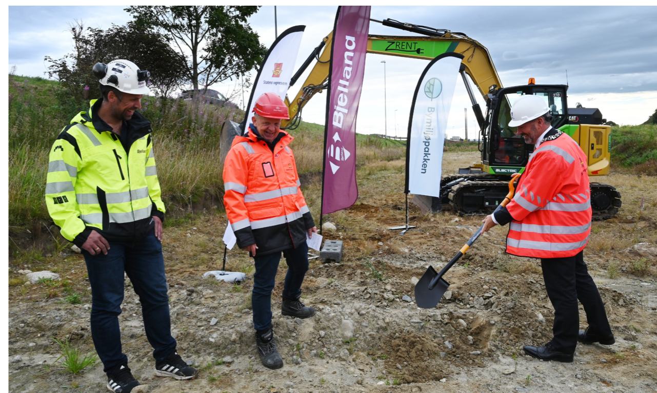
God stemning under spadestikk for Transportkorridor vest. Foto: Bymiljøpakken
