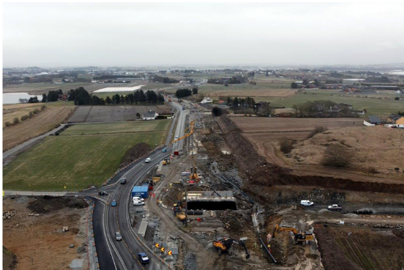
Dronefoto av arbeidet med Transportkorridor Vest. Foto: Statens Vegvesen
