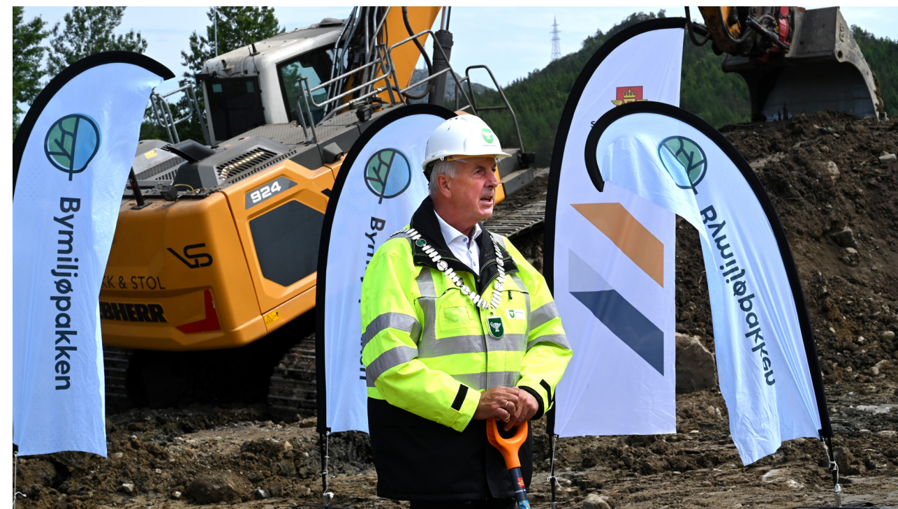
Sandnes-ordfører Stanley Winak tok første spadestikket for delstrekket Osli-Hove. Foto: Statens Vegvesen
