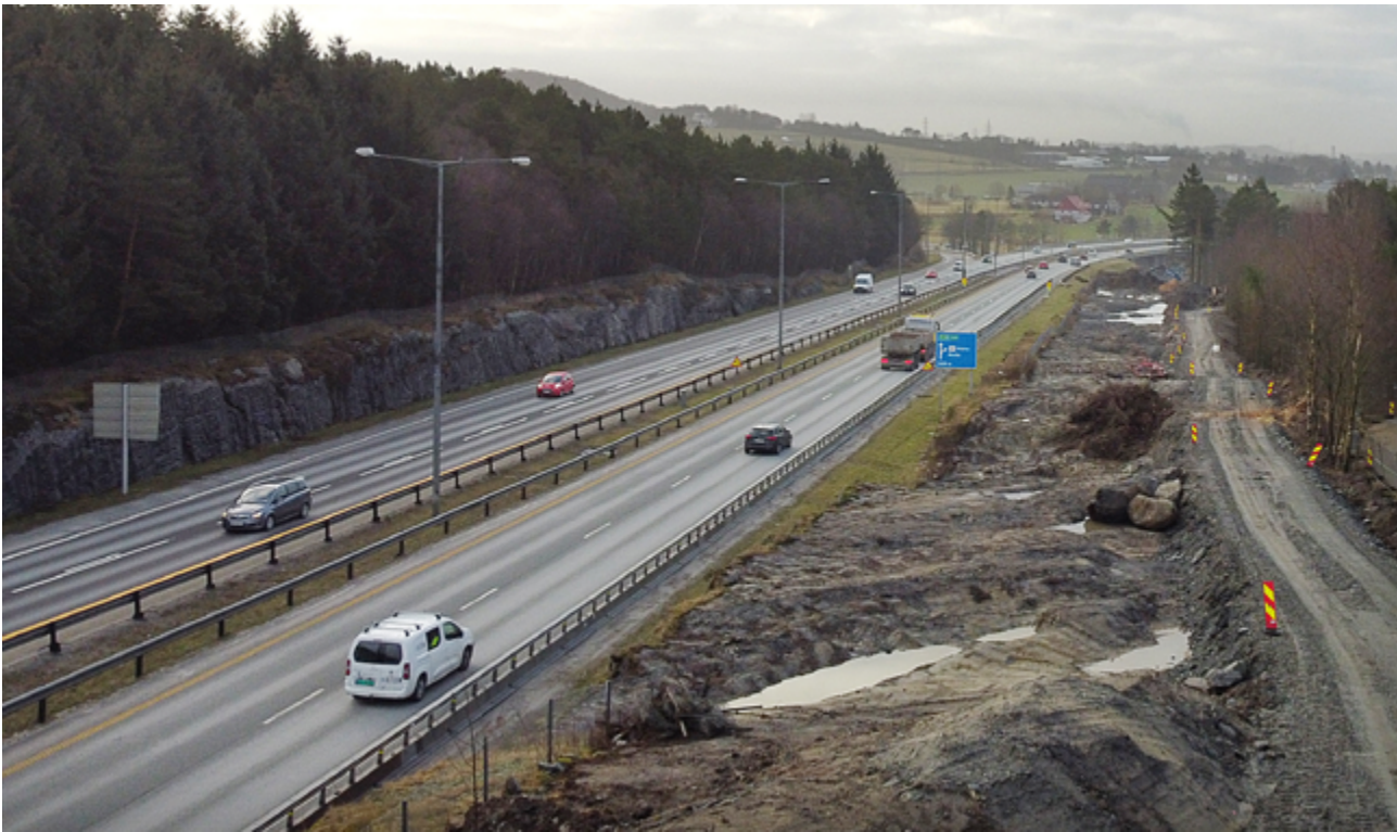
Sykelstamvegen under arbeid. Foto Øyvind Ellingsen/Stasjons Vegvesen
