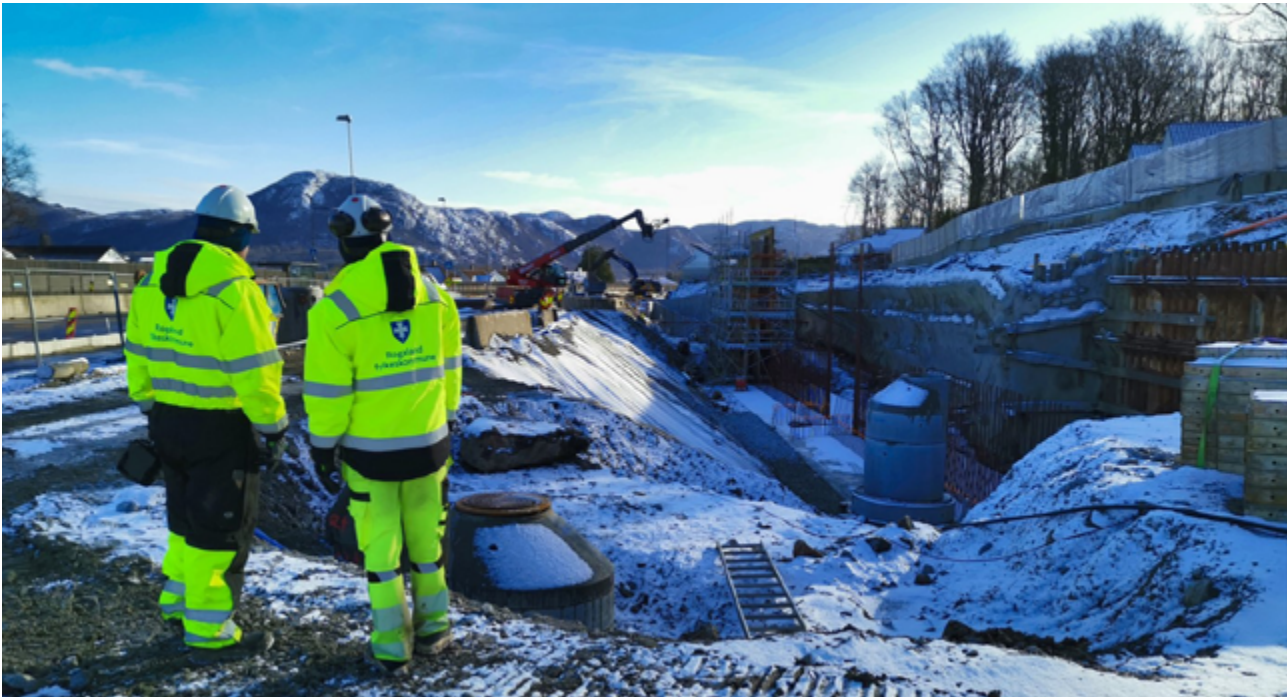
Bussveien under arbeid
