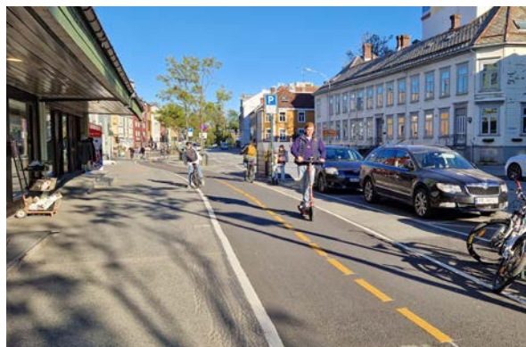
Sykkelvei med fortau skilt fra øvrig trafikk med møbleringssone og langsgående parkering, Fjordgata i Trondheim.
