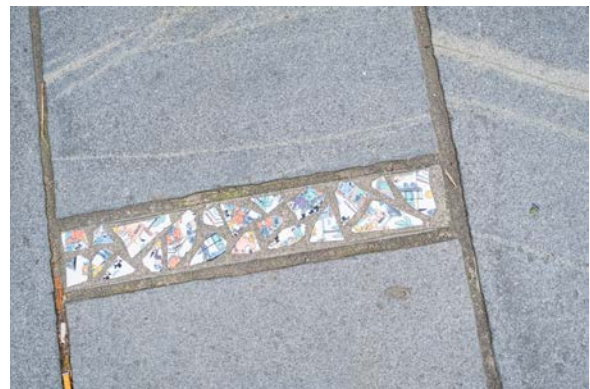
Materialer og opplevelser - det lille ekstra. Små skår av Figgjoporselen felt inn mellom graniitteller.
