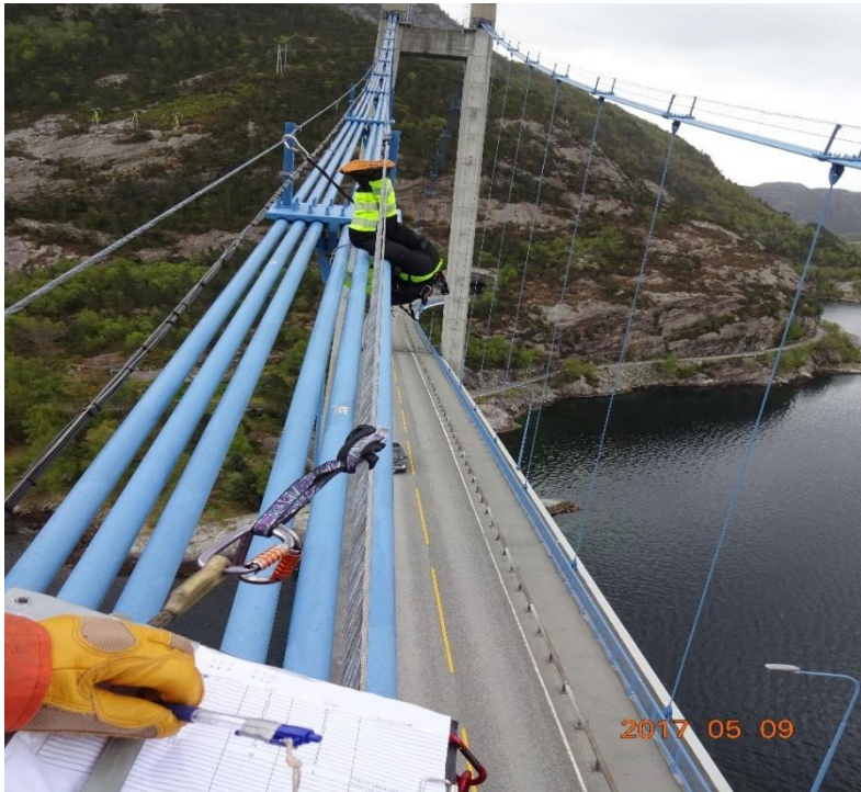
Vedlikehold og ettersyn høyt oppe i Lysefjordbrua.
